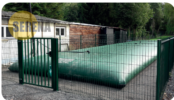
Nadzemná protipožiarna nádrž
